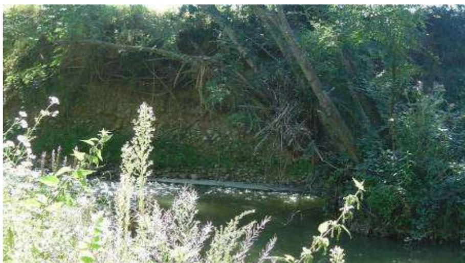
Figure 20 : érosion de berge en rive gauche ~ 200 mètres en aval du gué
